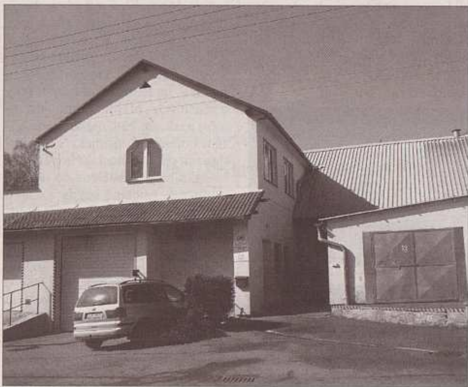
Na snímku je budova jatek a chladicí box v Oudoleni
