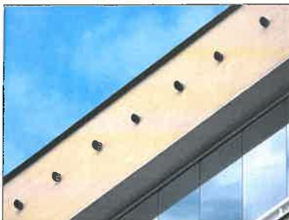
Ukázka nesprávného provedení opatření, trubky vyčnívají spodními okraji ze zateplené fasády a jsou pro rorýse jen obtížně překonatelnou překážkou
